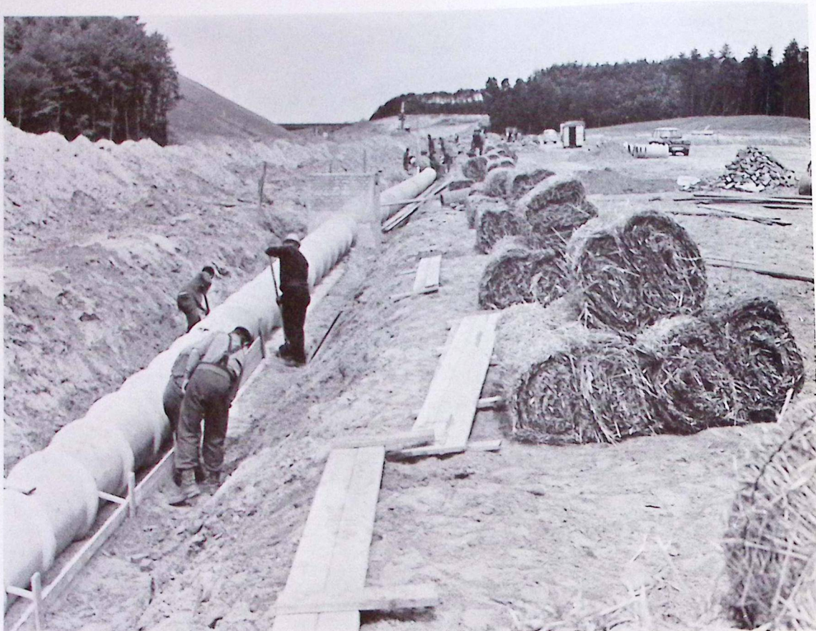
Un important drain sous la berme centrale accompagne la descente sur Wauthier-Braine. Il sera protégé contre la poussée des terres au moyen de paillons.
