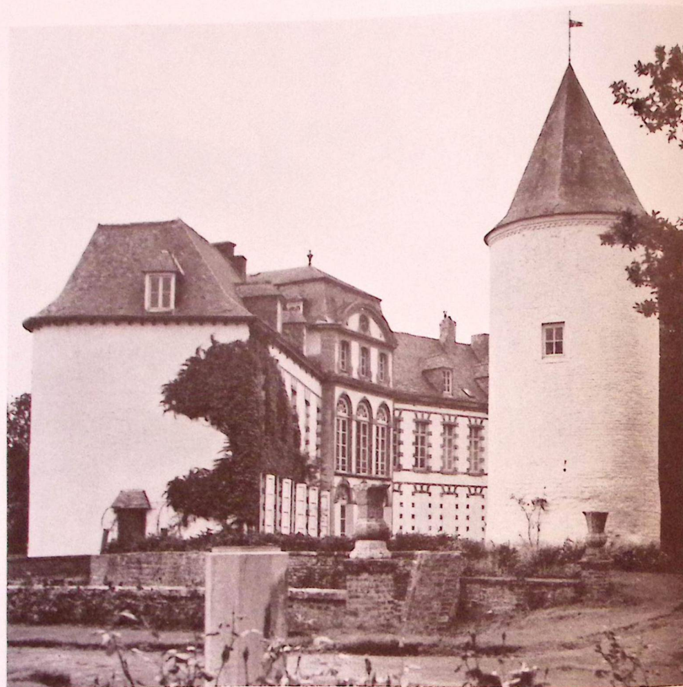
Château de Bois-Seigneur-Isaac: Tour ronde, isolée du bâtiment principal et remontant à la forteresse primitive
