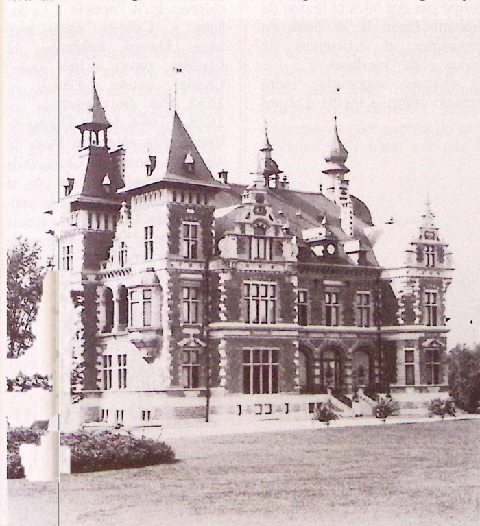
Le château des Cailloux à Jodoigne (30 juillet 1890).
