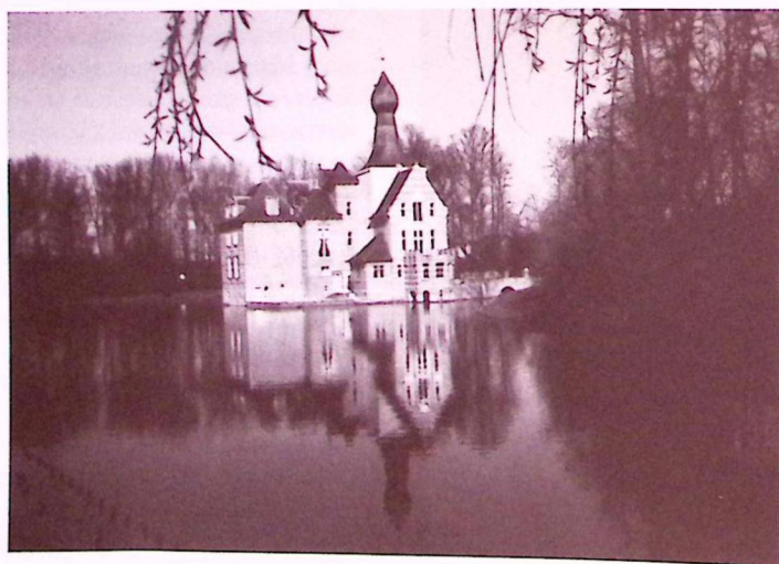
Le château de Riveren à Ganshoren fut également propriété des Villegas. Très massif, il est facilement reconnaissable grâce à son toit en forme de bulbe. Son superbe parc est accessible deux dimanches par mois. (Photo J. Georis)
