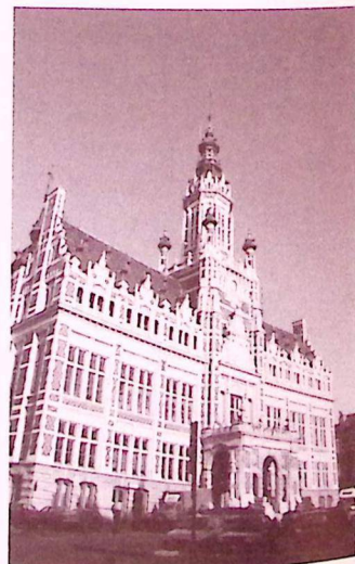
Hôtel Communal de Schaerbeck érigé en 1885. Toutes les façades de cet édifice ont été exécutées en briques de parements de «Tubize». (Photo : J. Bierrewaerts).
