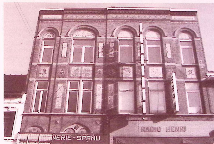
Rue de Bruxelles à Tubize. Façade exécutée en majolique. (Photo : J. Bierrewaerts).
