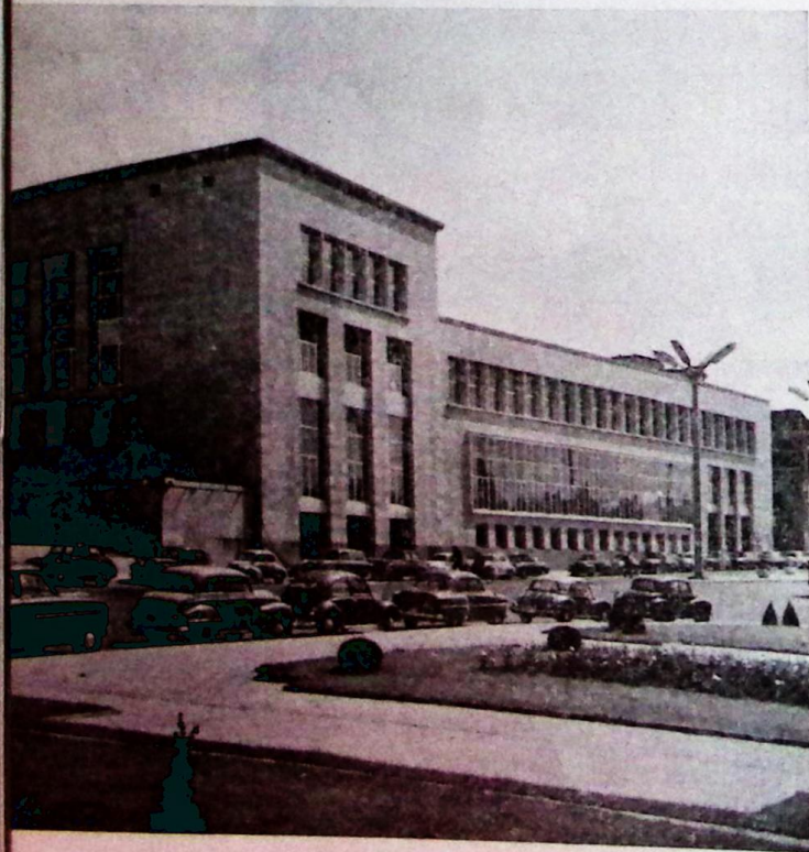
Ces nouveaux locaux abriteront bientôt la Bibliothèque Royale.
