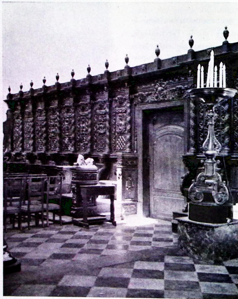
HOEGAARDEN — Les stalles baroques sont enrichies de feuillages et proviennent de l'abbaye d'Heylissem.
