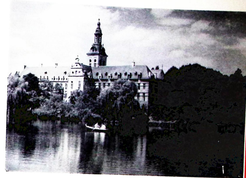
HEVERLE - L'ensemble impressionnant formé par l'abbaye de Parc à laquelle on accède par cet escalier monumental. (Photos de Sutter)
