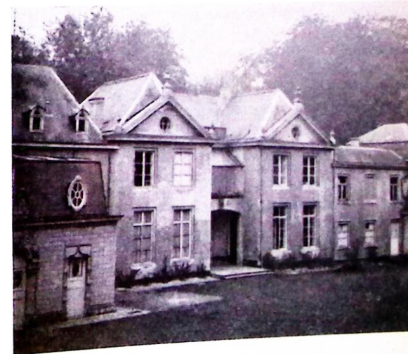
La façade postérieure.
