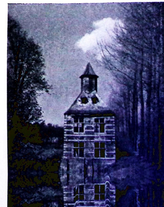
A l'extrémité du domaine un pavillon de chasse du XVI e siècle.
