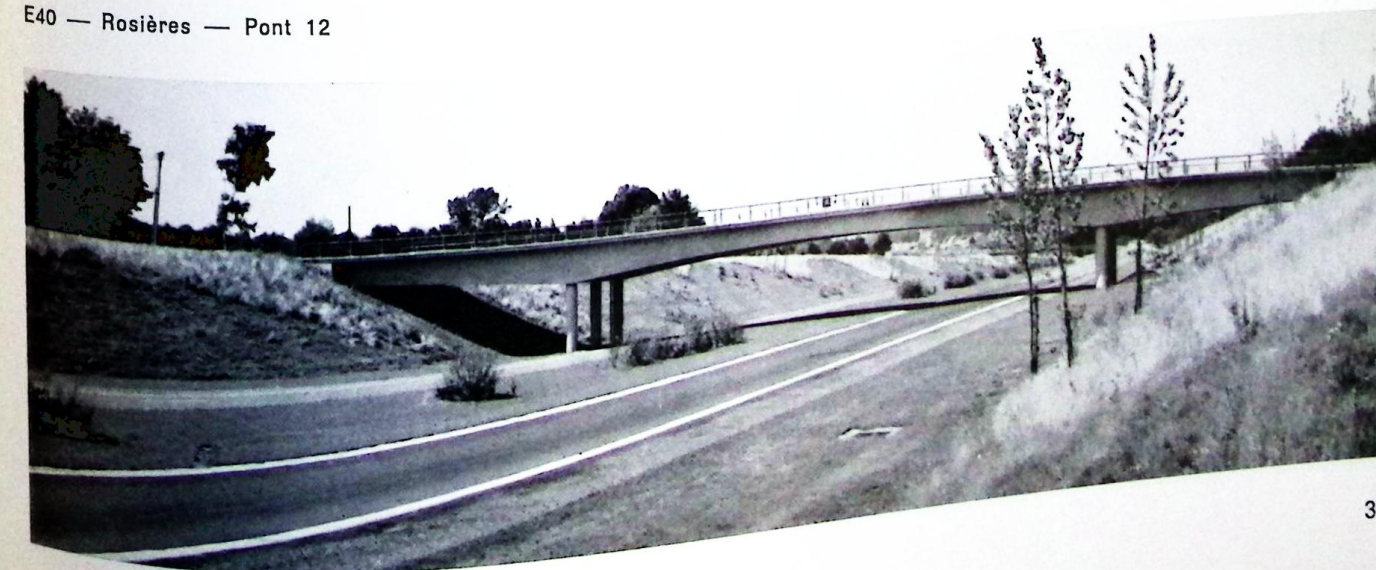
E40 — Rosières — Pont 12
