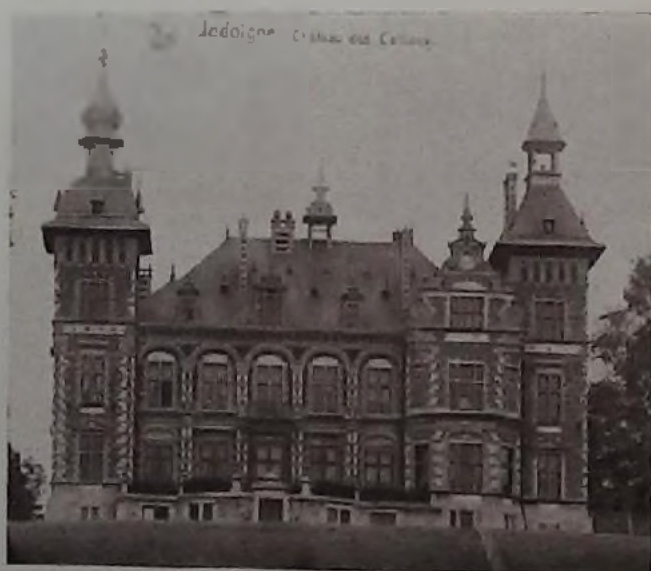
Fig. 44 : Le château des Cailloux avant sa transformation.
