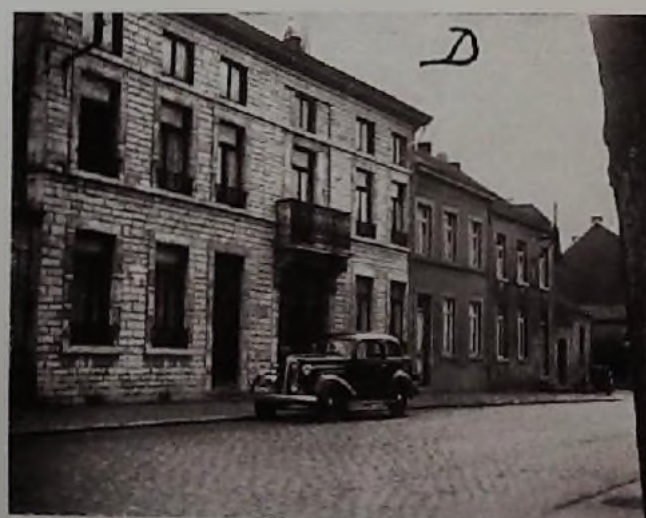
Fig. 40. — Chaussée de Tirlemont, 22. (Photo J. Clément).
