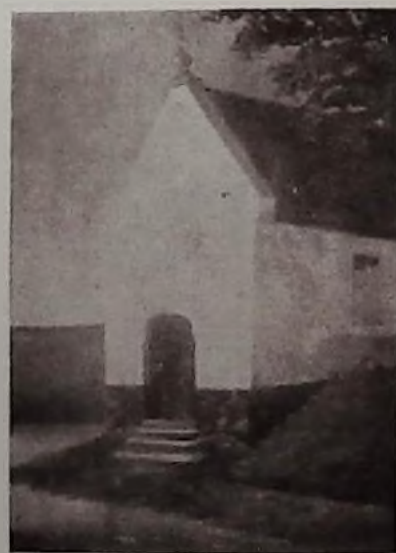
La chapelle du Caillou avant sa démolition.
