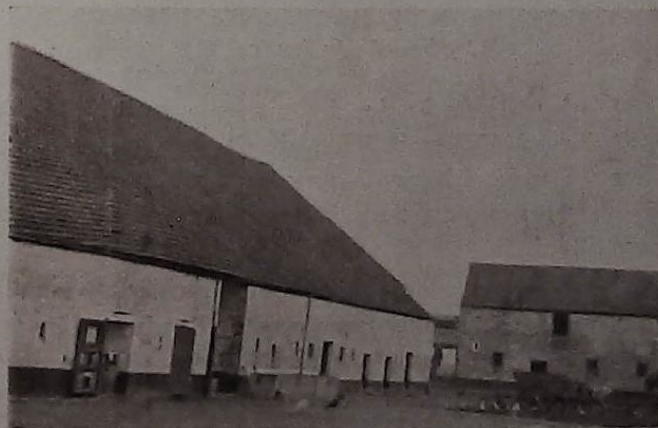
Etables et Ecuries. Au centre emplacement du fumier.
